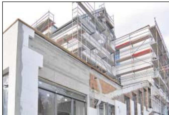
Aufgestockt und angebaut - das ehemalige „Franzosenhohl“ präsentiert sich in ziemlich neuer Optik.
