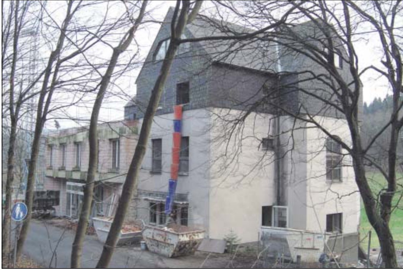
Bevor das „Literaturhotel Franzosenhohl“ seinen Betrieb aufnimmt, erfolgen umfangreiche Renovierungsarbeiten. Foto: May
